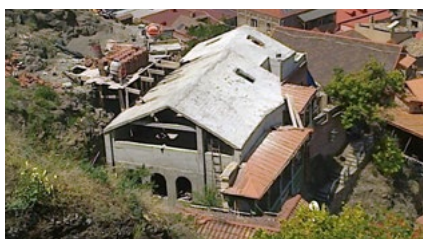
▲ A Mtacminda-hegy alatt tervezett családi háznál alapvető követelmény lehetett a biztonság. Beton nyeregretető, beton főfalak. Fotó: Szilvási
