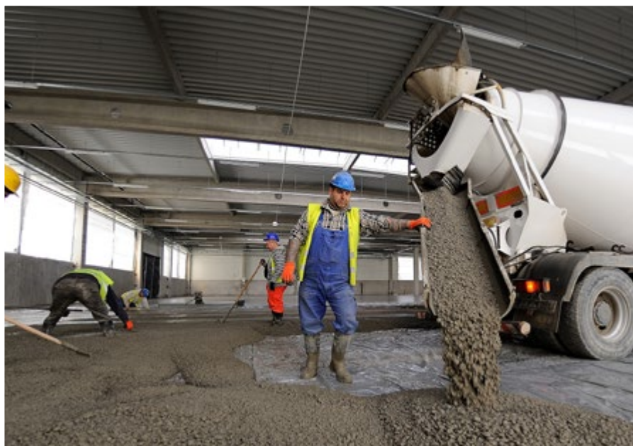
▼ ipari padló betonozása
