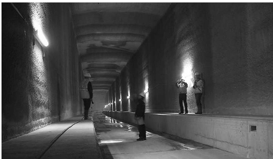
1. ábra A Söderleds főút alagútja Svédországban
