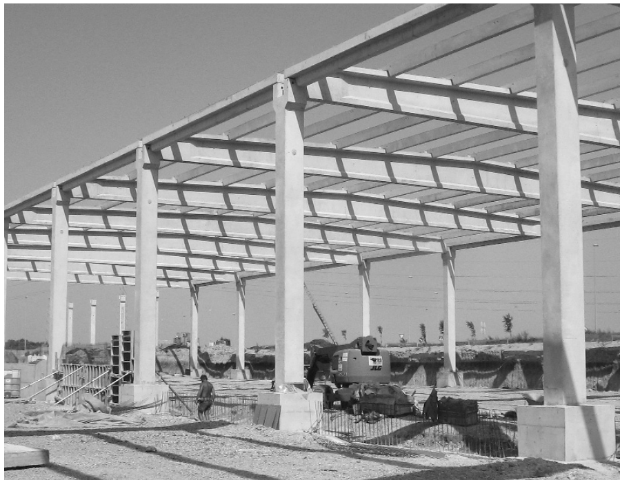
3. ábra A Fulgar cérnagyár nagybecskereki, 30x12 m pillérállású gyártócsarnoka 2007-ben
