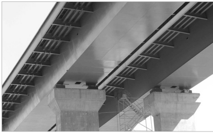
8. ábra A szabényi-völgyhíd korrózióvédő bevonattal ellátva
