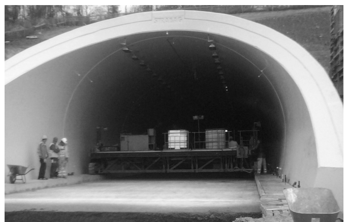
7. ábra A pályaszerkezet betonozása
