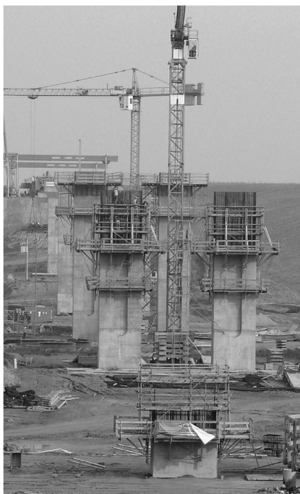
1. ábra A szebényi völgyhíd pilléreinak építése
