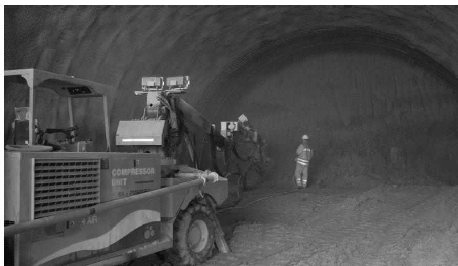
2. ábra Betonlövés Sika PM 500 PC típusú berendezéssel
