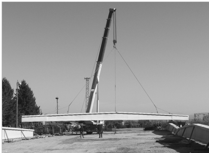
5. ábra 35 m fesztávú gerenda áthelyezése az Asalbelik gyártótelepén
