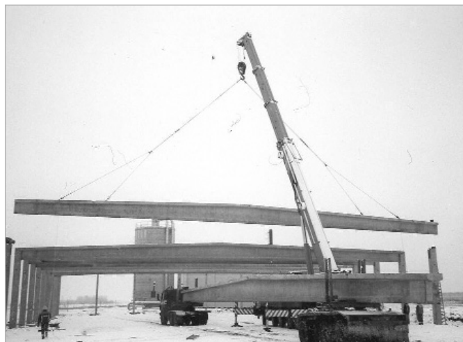
2. ábra A fertői Velux raktárcsarnokának 32 m feszítávú tetőszelemenjei 2002-ben
