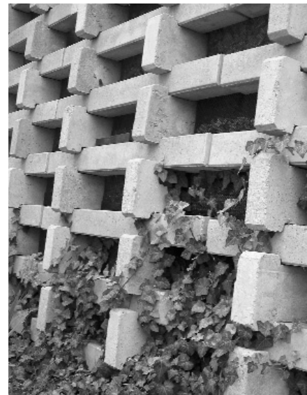
2. ábra Megépült máglyatámfal Komlón
