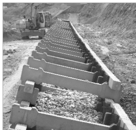
1. ábra Épülő fal Kelenföldön, a 4-es metró területén
