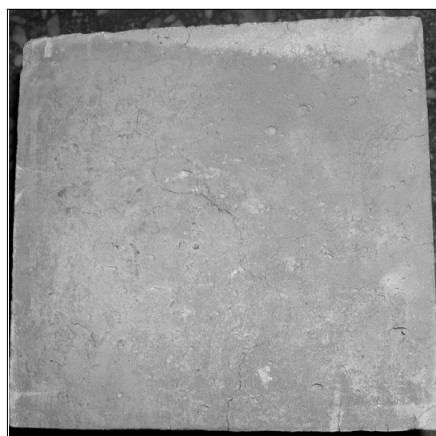
5. ábra CEM III/A 32,5 N jelű cementtel készült beton repedésképe a 800 °C-os hőterhelést követően
