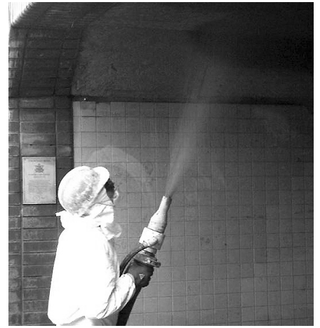
2. ábra A tűzvédő habarcs felhordása
