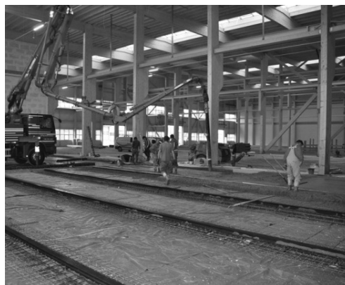
2. ábra Referencia épület: ABB gyártócsarnok Kleindöttingenben, Svájcban. A 18 cm vastag ipari padló, a lépcsőházi falak és a felvonó falazata, a homlokzati előregyártott elemek szálerősítéses betonból készültek (Concrix, 3,0 - 4,5 kg/m 3 )
