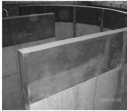
4. ábra A Budapesti (csepeli) Központi Szennyvíztisztító Telep szulfátálló cementtel, vízáró betonból épült eleveniszapos medencéje
