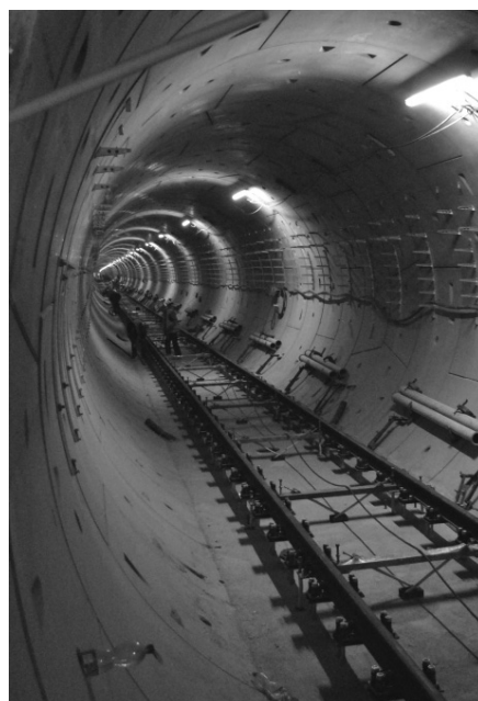
1. ábra Betonozáshoz előkészített vágányszakasza a metróalagútban
