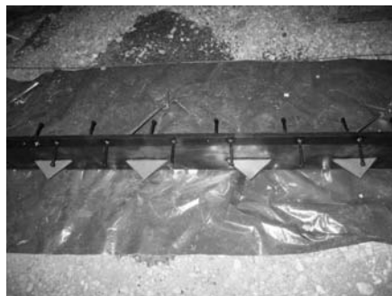
5. ábra Dilatációs profil elhelyezése a munkahézagoknál
