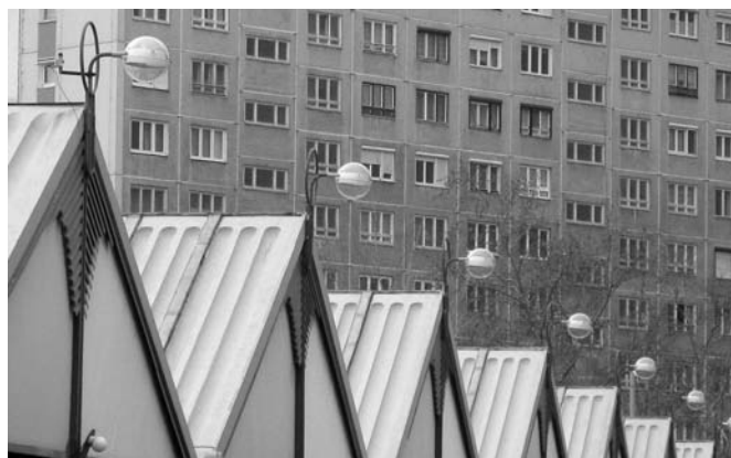
2. ábra Az óbudai Kórház utcai piacszarnok vízzáró vasbeton tetőszerkezete
