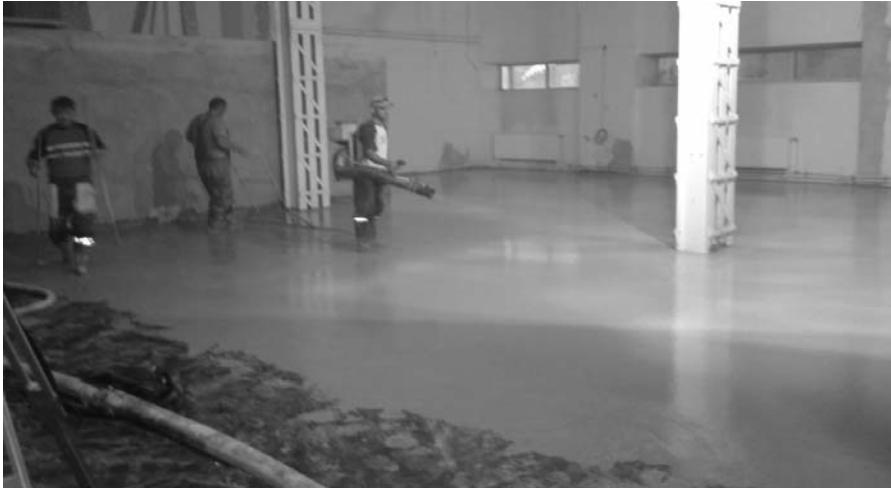
4. ábra Készül a CemFlow padló
