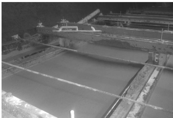
4. ábra Szilárdul a beton a Pilisvörösvár-Piliscsabai alagútban
