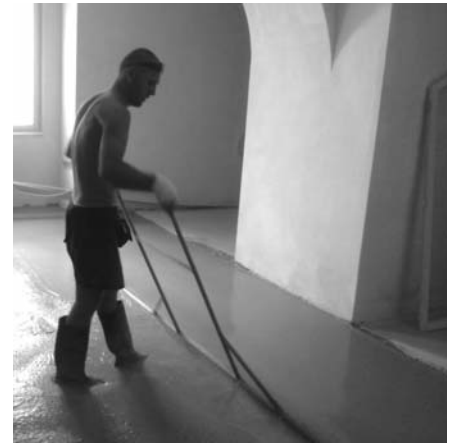
3. ábra A beton mozgatása nyeles egyengető szerszámmal
