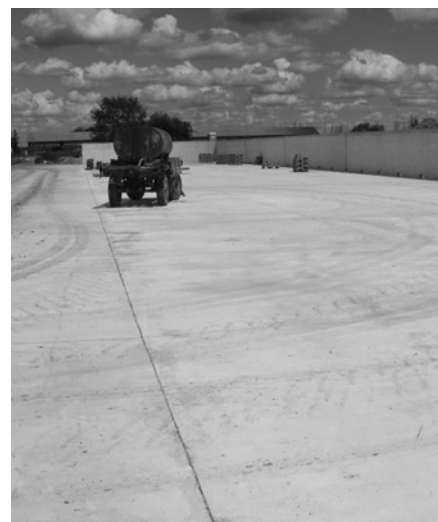
2. ábra Silótároló építés közben
