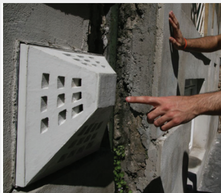
1. ábra Gázköpő - konvektor szellőző
