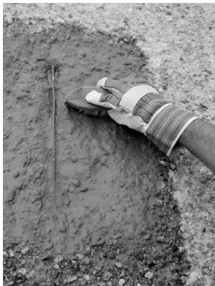
1. ábra A tapadásjavító habarcs felhordása a felületre
