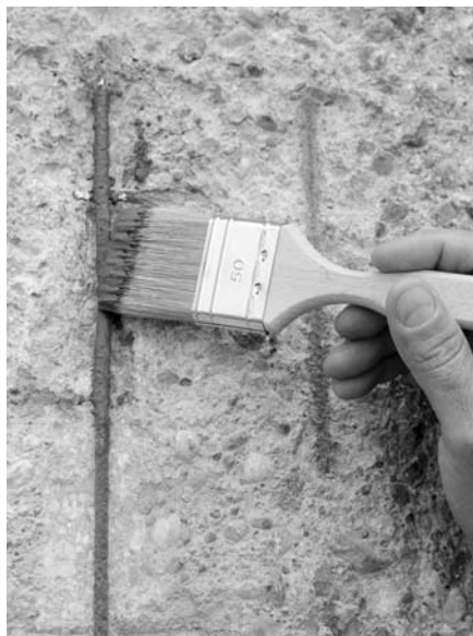
2. ábra A betonacél védelme Repol BS7 szerrel
