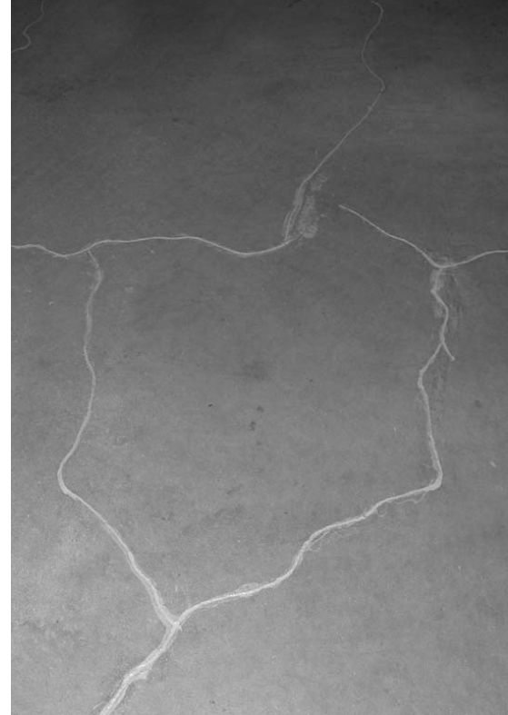
2. ábra Repedések keletkeztek a padlóban
