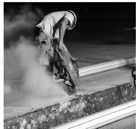
3. ábra Precíz munkavégzés nehéz körülmények között
