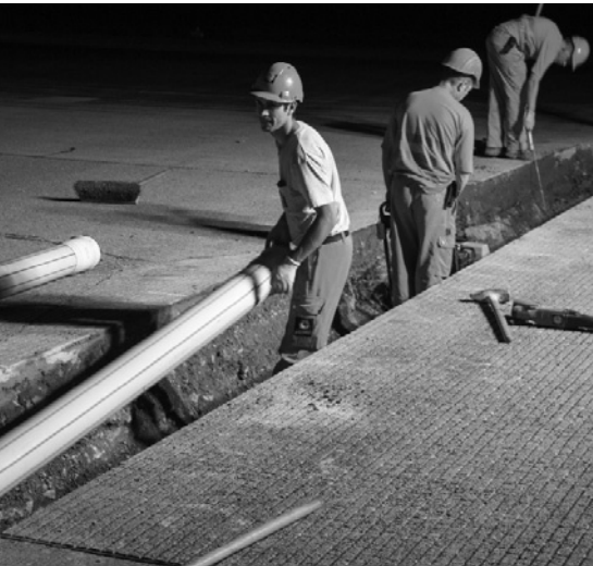
4. ábra A kábelvédő csövek elhelyezése
