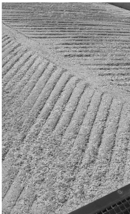
1. ábra Beton felfagyási hiba
