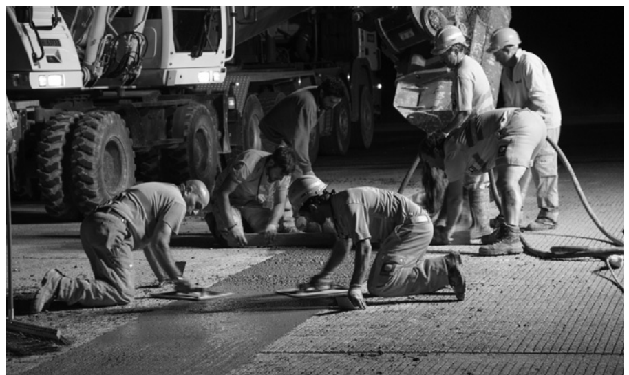
6. ábra Nagyon fontos a beton síkjának pontos kialakítása
