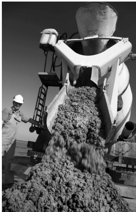
3. ábra A mixerbeton szállítása a lehető legrövidebb ideig tartson
