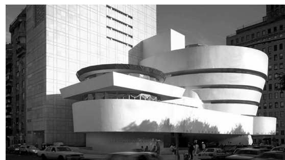
1. ábra Guggenheim Múzeum, New York betonjavítási munkák
