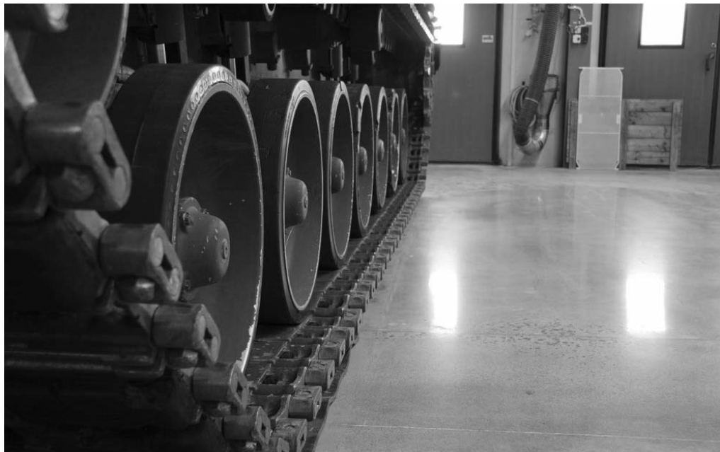
5. ábra A gyémántcsiszolás eltávolítja a beton leggyengébb, porlódó rétegét, és felszínre hozza annak kemény, belső szerkezetét
