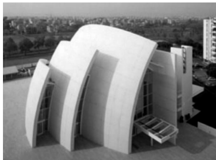
4. ábra Nagy teljesítőképességű látszóbeton reaktív metakaolinnal és fotokatalitikus cementtel, Misericordia templom, Róma (internet6)
