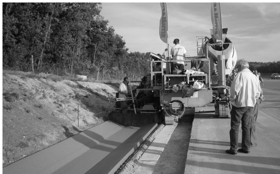
4. ábra A vízvezető folyóka betonozását késő délutánra tették
