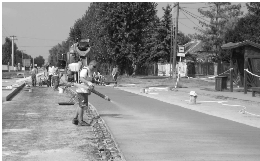
5. ábra Párazáró szer permetezése a frissen betonozott felületre
