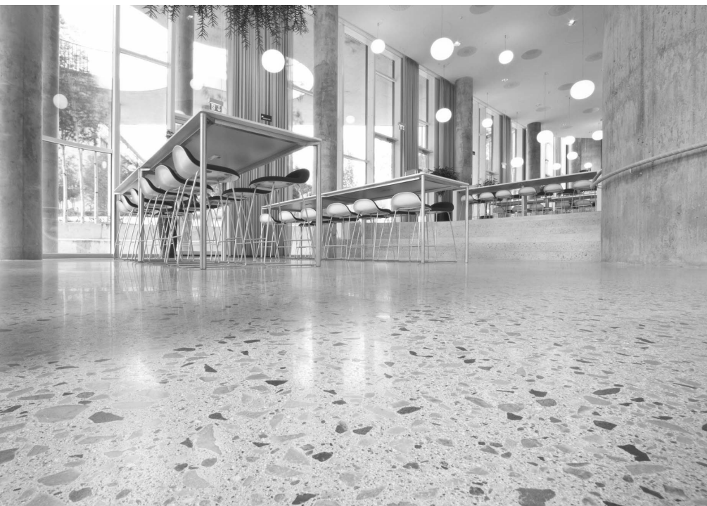
1. ábra A felszínre került kőváz azon túl, hogy strapabíró, rendkívül esztétikus is
