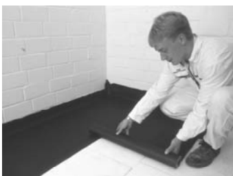
6. ábra Elválasztó fólia fektetése
