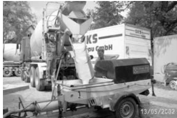
1. ábra Szállítás mixerrel
