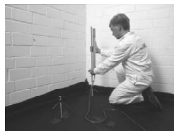
7. ábra Padlószint mérése és jelölése
