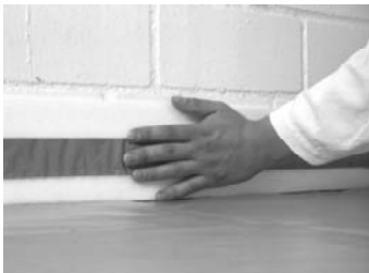
4. ábra Perem szigetelése
