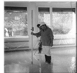
3. ábra Mérés, tömörítés
