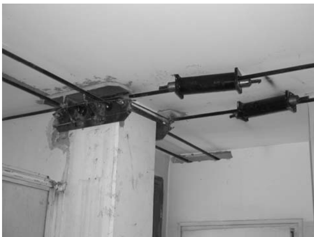
14. ábra Feszítópázmák megvezetése a födémlemezeket alátámasztó acél-gallérban
