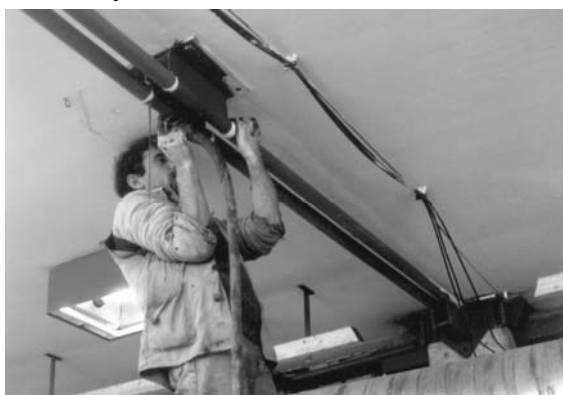
10. ábra Szabadon vezetett feszítőkábelek lefeszítése a fűdémmezőben
