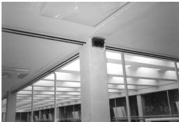
11. ábra Fűdém alatt és a pillérsíkon belül vezetett feszítőkábelek
