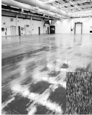
1. ábra Az előkészített alapfelület
