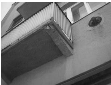
1. ábra Felújításra váró vasbeton szerkezetű erkélylemez
