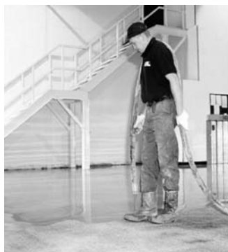
2. ábra Bedolgozás géppel
