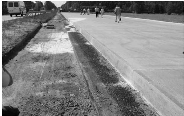
6. ábra Pályaszerkezeti rétegek
