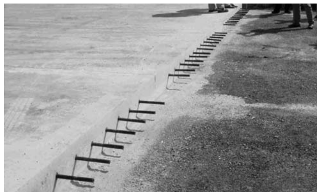
7. ábra Keresztirányú hézagvasalás beépített állapotban
