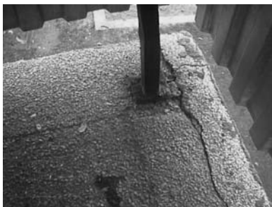
2. ábra A fagykárt szenvedett erkélylemez széle
