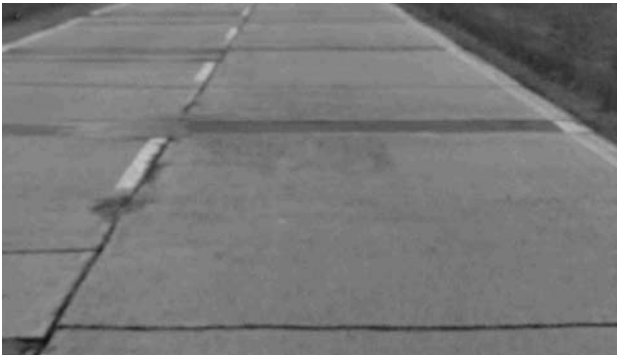
1. ábra A felújítás előtti betonút
