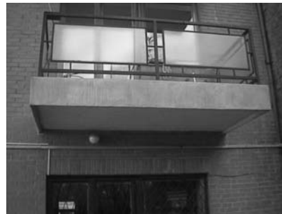
3. ábra Murexin Repol rendszerrel készített erkélyszegély
