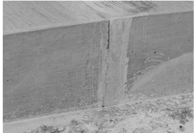
3. ábra Keresztirányú fuga kialakítása a tervezett repedéssel
