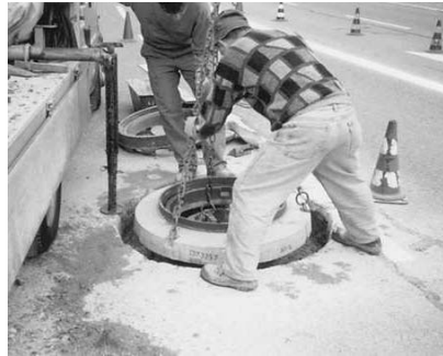
A Sika FastFix-4 bedolgozása és az aknaelemek rögzítése
