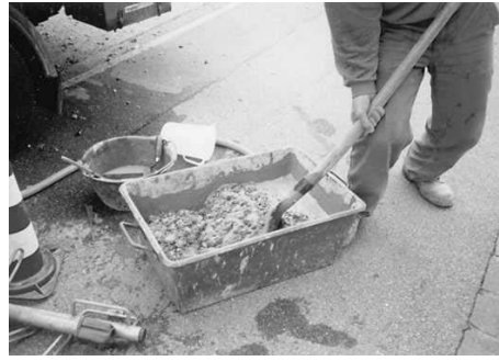
A Sika FastFix gépi és kézi eljárással is keverhető
