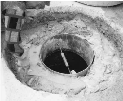
A Sika FastFix-4 bedolgozása és az aknaelemek rögzítése
