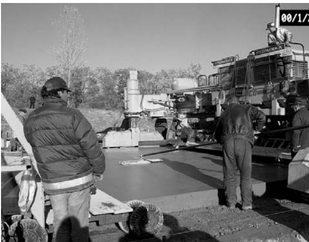
5. ábra A beton felülete a terítés után
