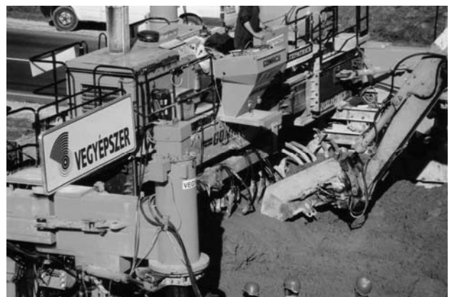
4. ábra A beépítő gépsor munka közben
