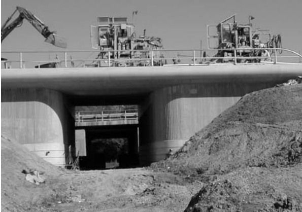
2. ábra Kétrétegű burkolat építése átmenő szerkezet nélküli rövid hídon
