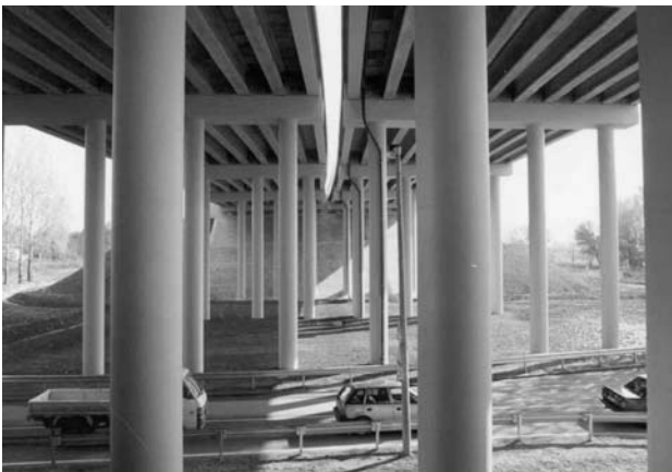
3. ábra Hídszerkezet alulnézetből
