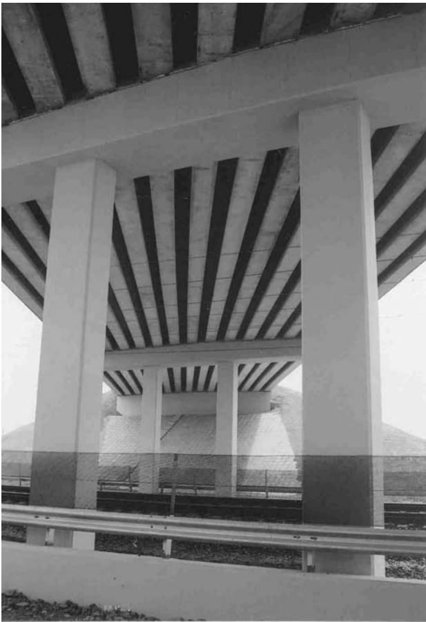
3. ábra Hídszerkezet alulnézetből
