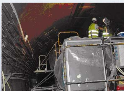
Fátyolinjektálás előkészítése
