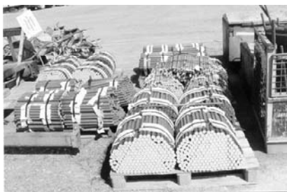
1. ábra A betonút kellékei közül: gondosan előkészített tűskék
