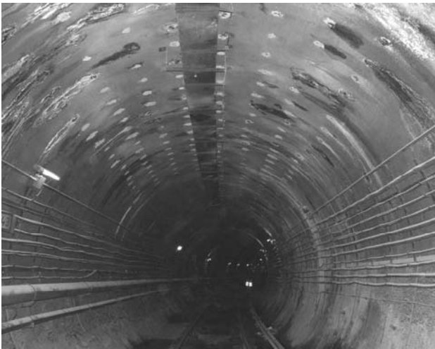
1. ábra Fátyolinjektálás során visszajavított furatok
