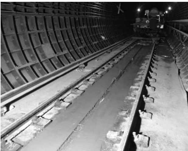
2. ábra Folyóka betonozás után
