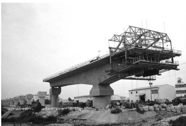
5. ábra A felszerkezet építése
