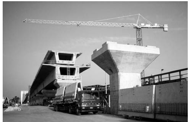
2. ábra Építés közben
