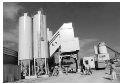
3. ábra 300 m 3 /óra teljesítményű mobil betonüzem, amelyet a sztrádaépítés betonigényének kiszolgálására telepítettek
