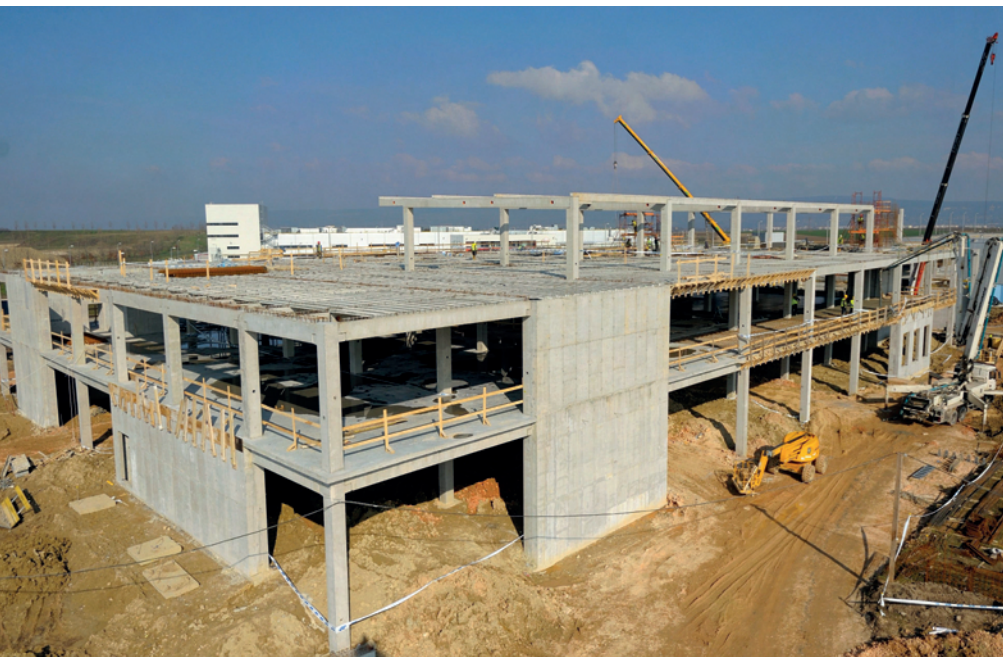
1. kép A fecskendőgyár épülő váza. A tartószerkezet kivitelezője az ASA Építőipari Kft.
