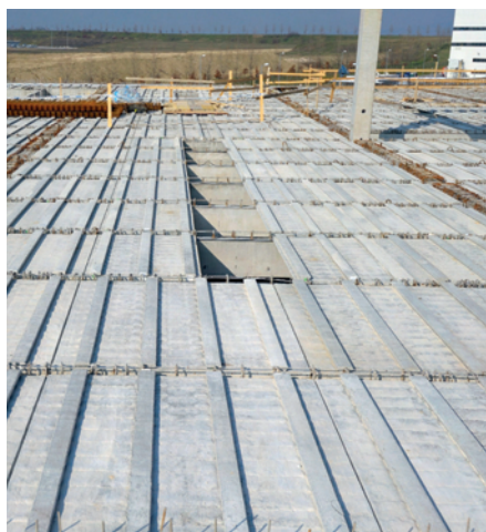
3. kép A felülbordás zsalupanelekre a vasszerelés közvetlenül ráfektethető
