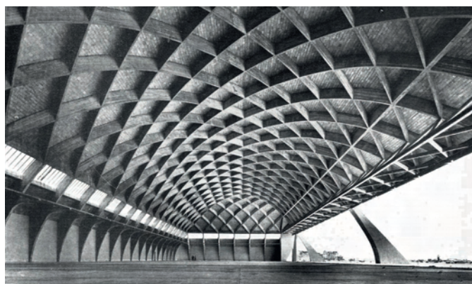
4. kép Repülőgép hangár héjszerkezete
