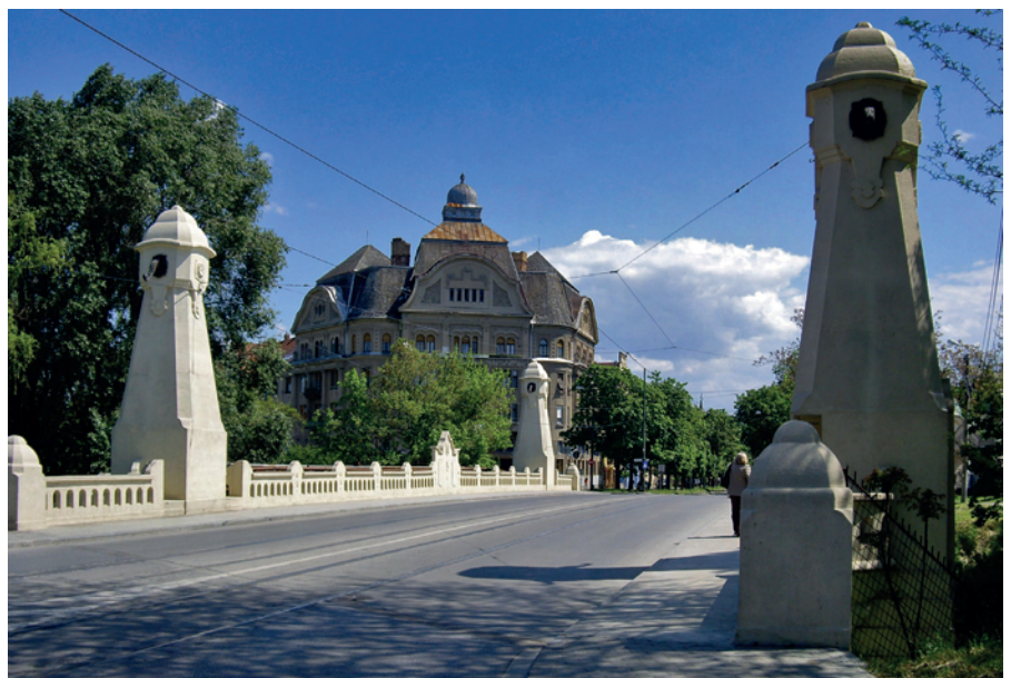
2. kép Az oszlopok eltolódása nem optikai csalódás, a híd ferdén keresztezi a Bégát
