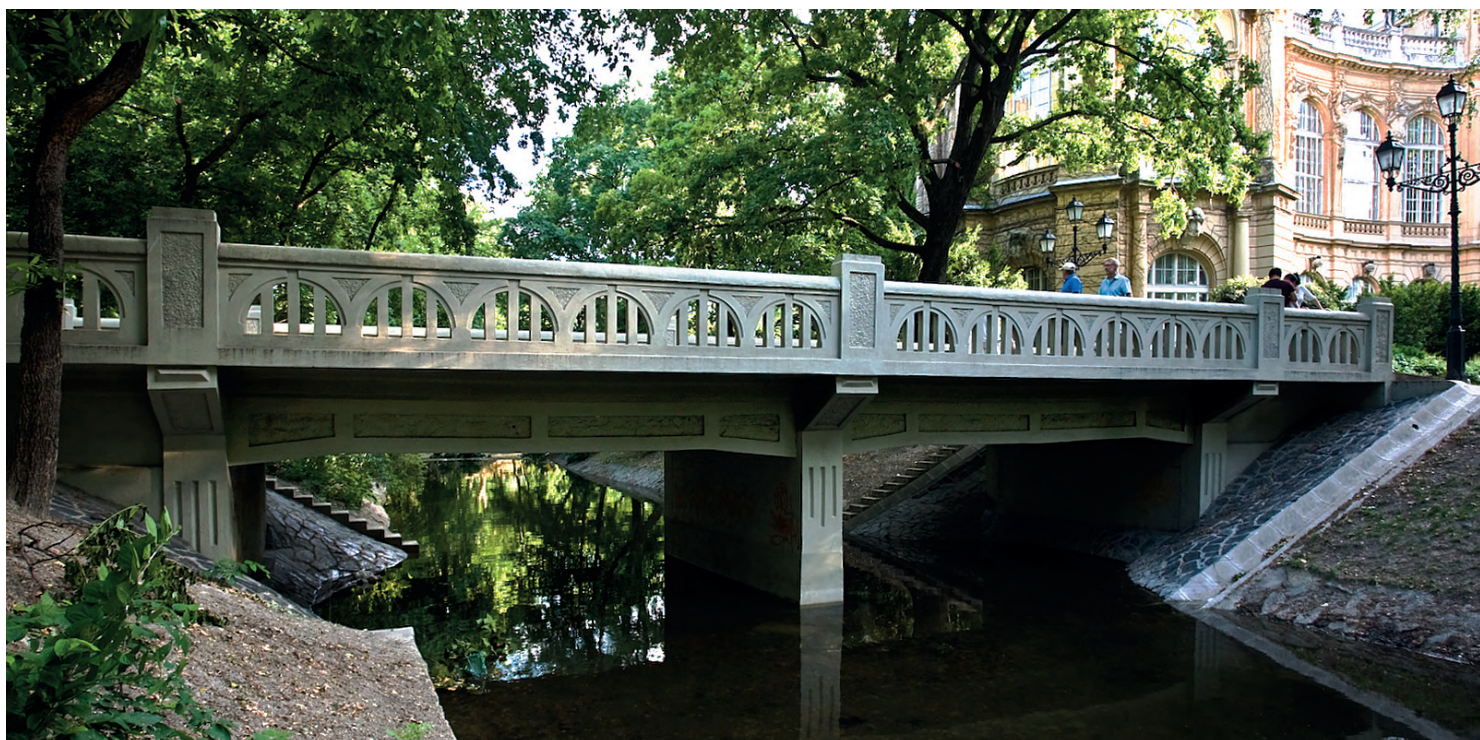
5. kép A Mezőgazdasági Múzeumhoz vezető út vasbeton hídja a Városligetben
