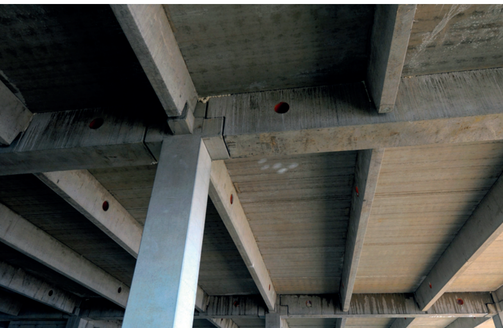
2. kép A tartószerkezet alulnézetből
