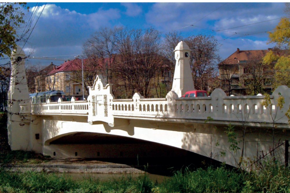
1. kép A Liget utcai híd Temesváron, a Béga-csatorna felett vasbeton gerendahíd
